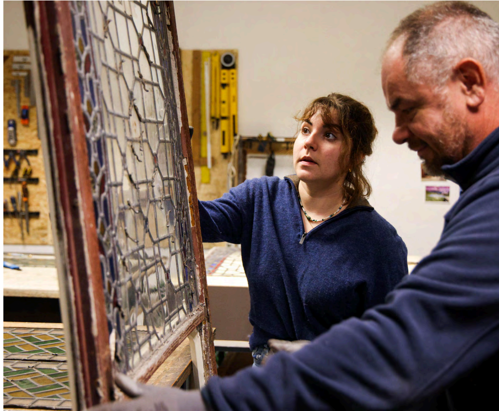
Dans le petit atelier d'Isles-sur-Suippe, Sébastien Niedergang et Julie Menu doivent restaurer une centaine de vitraux de la cathédrale de Paris, en changeant notamment des éléments de plomb. Remi Waffart
